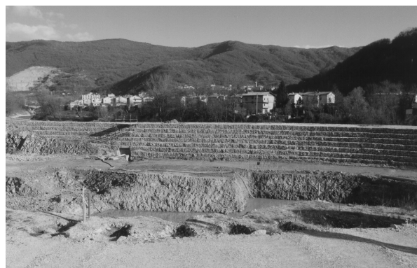
Slika 2: Gradbena jama za strojnico in tlačni cevovod HE Plave II; v ozadju je varovalni nasip gradbene jame proti visokim vodam Soče z gabionsko zaščito na notranji in zunanji strani
