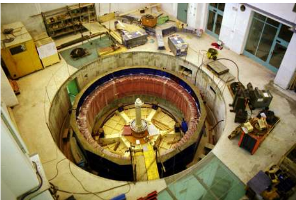
Slika 2: Montaža generatorja
