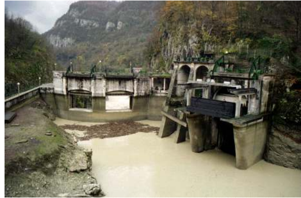
Slika 8: Obstoječi vtok HE Doblar, v ozadju pregrada Podsela z odprtima prelivoma
