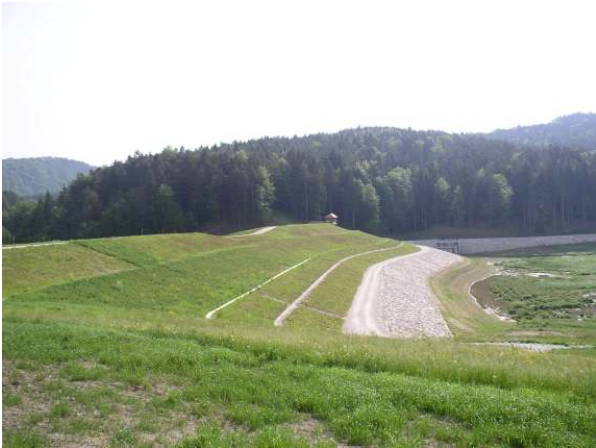
Slika 1: Pregrada Drtijiščica z boka
