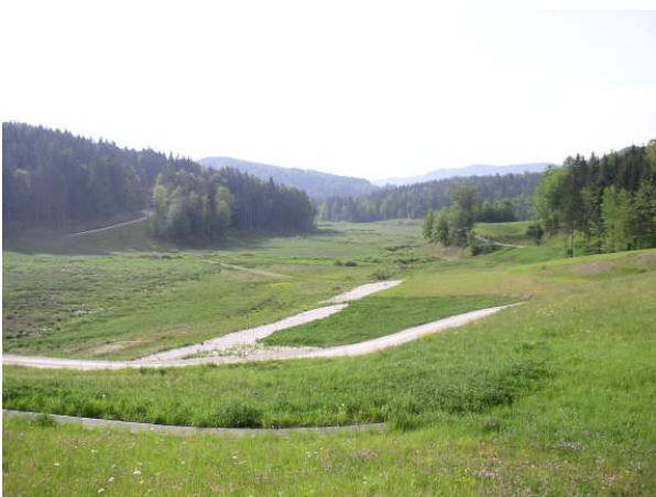
Slika 2: Trenutno prazna akumulacija Drtijiščica
