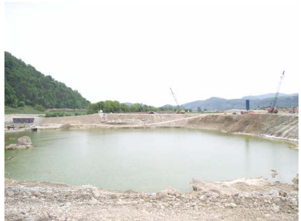
Slika 3: Gradbena jama HE Boštanj
