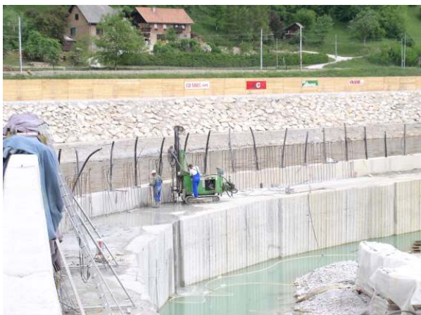
Slika 4: Zaščitna stena gradbene jame HE Boštanj od blizu
