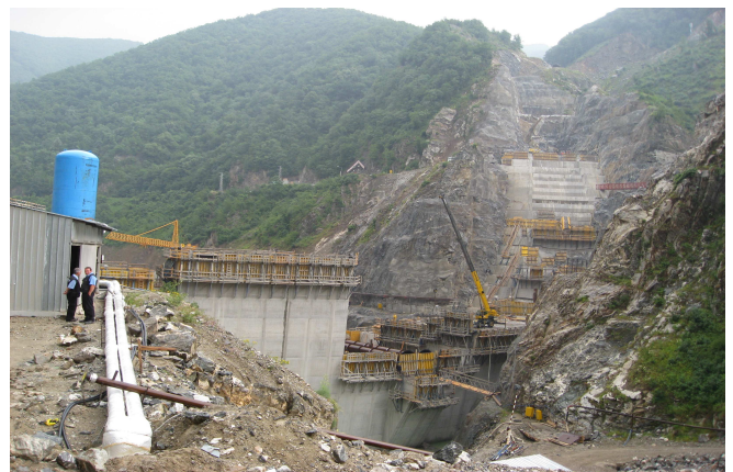
Gradbišče pregrade Cankov Kamak
