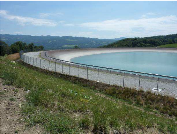
Zgornji bazen – Pogled na pregrado Kanalski vrh 2.
