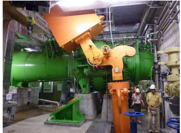
Kladivce in nakovalce kroglastega zasuna, ki se zapre v 37 s.
