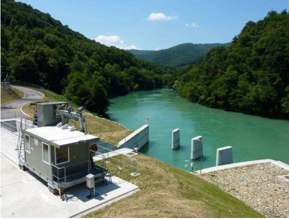
Vtočno iztočni objekt s čistilnim strojem.
