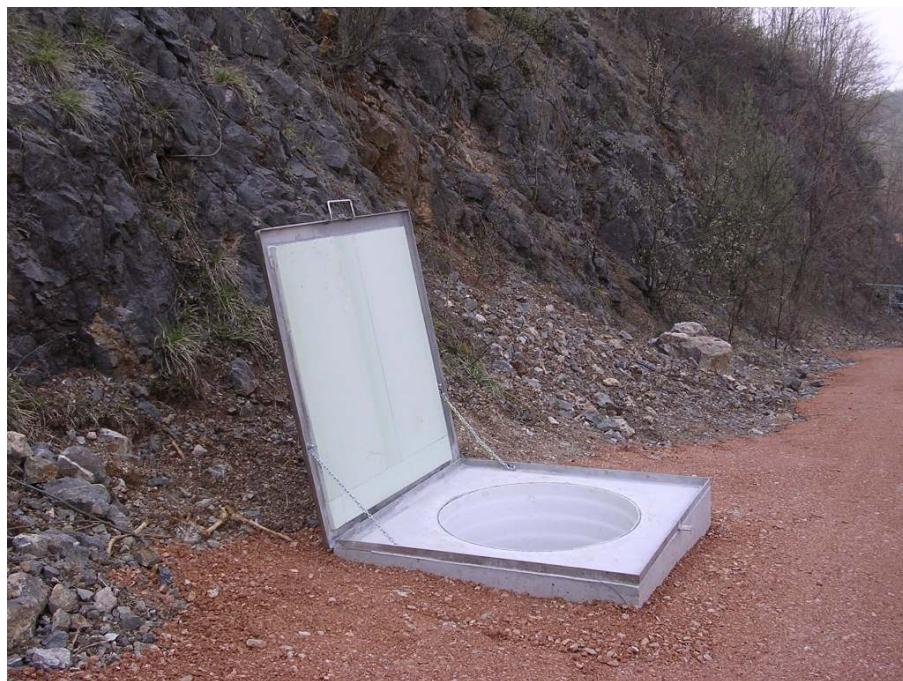
Slika 4: Izveden jašek na levem boku (izven telesa pregrade)
